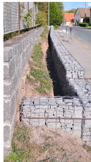
Gabionová opěrná zeď při silnici III/18329 foto: OÚ
