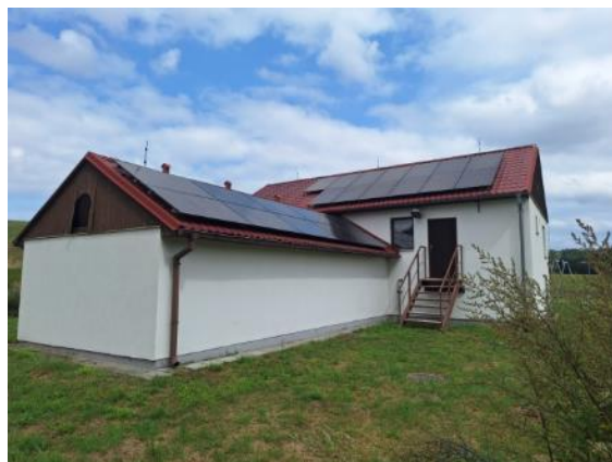
Foto FVE na budově ČOV
