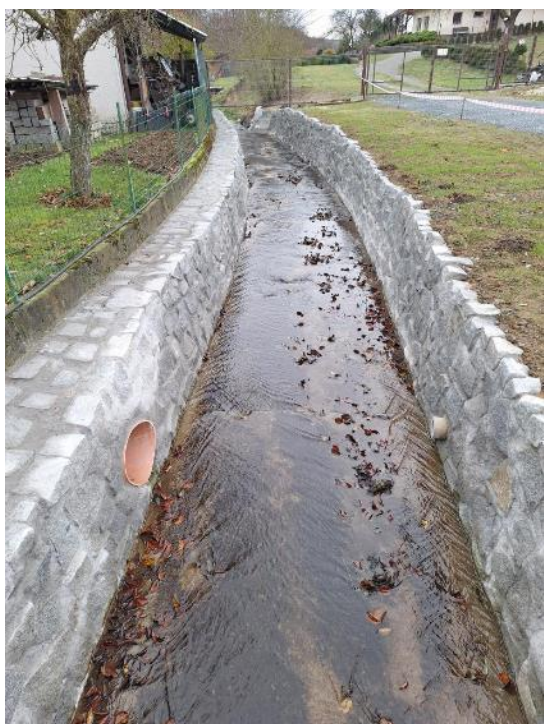
Foto opravy koryta potoka v N. Borku
