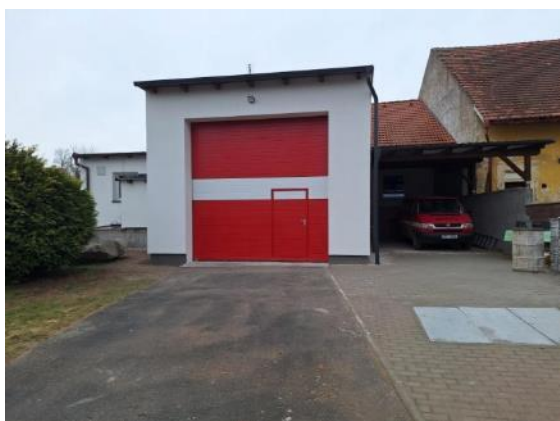
Foto přístavby hasičské zbrojnice
