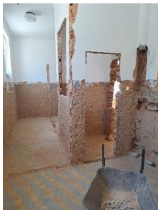
Stav po ukončení demoličních prací zdiva toalet a nově osazené vstupní dveře. Foto: OÚ
