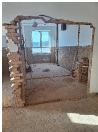
Stav po ukončení demoličních prací zdiva toalet a nově osazené vstupní dveře. Foto: OÚ
